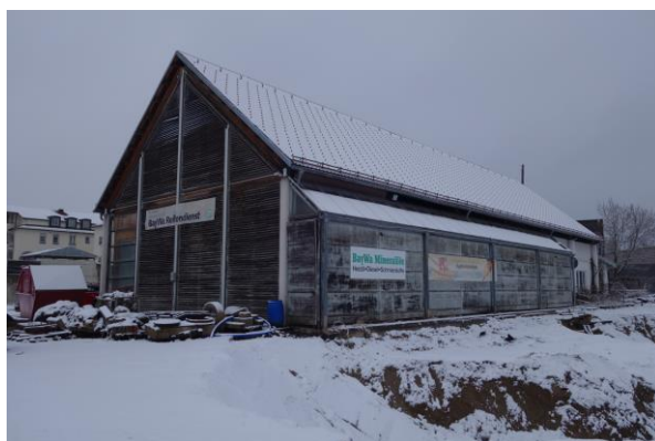
Abbildung 27: Westansicht Gabelsbergerstraße 14 (ehemaliges BayWa-Gebäude).
