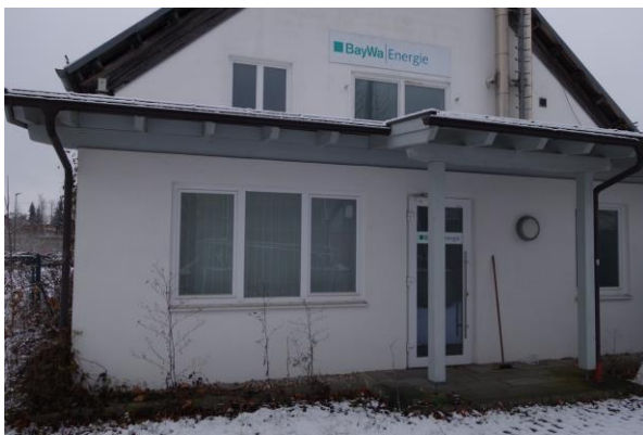
Abbildung 25: Ostansicht des BayWa Gebäudes.
