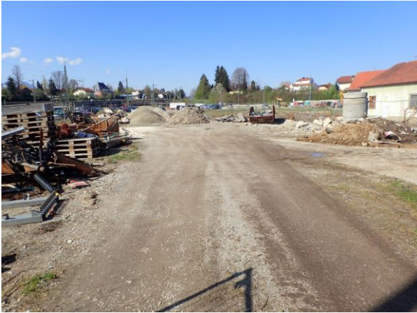
Abbildung 7: Große Teile des Geltungsbereichs werden als Lagerplatz für Baumaterialien verwendet (22.06.2022).
