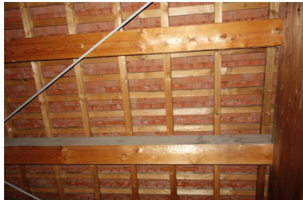
Abbildung 32: Ausschnitt der Dachkonstruktion.
