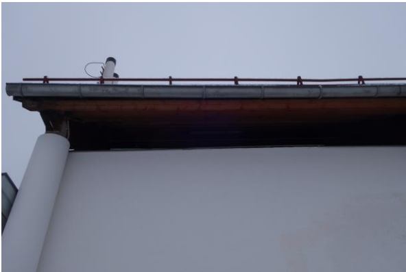
Abbildung 29: Zwischen der Dachkonstruktion und Außenmauer ist eine Einflugmöglichkeit für Fledermäuse vorhanden.
