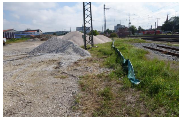
Abbildung 12: Zwischenlager von Baumaterialien und alter Reptilienzaun entlang der Bahnstrecke (28.07.2022).
