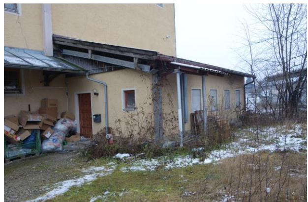
Abbildung 18: Anbau auf der Rückseite Gebäude Gabelsbergerstraße 1.
