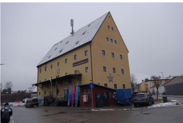
Abbildung 17: Ostansicht Gebäude Gabelsbergerstraße 1.
