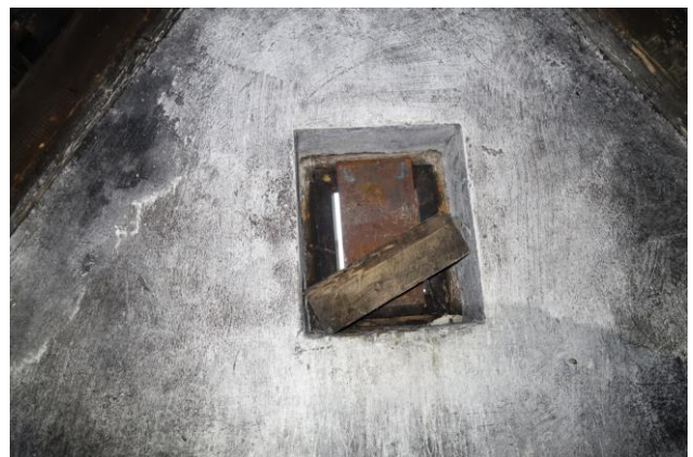
Abbildung 22: Die beiden ost- bzw. westseitigen Fenster sind geschlossen.
