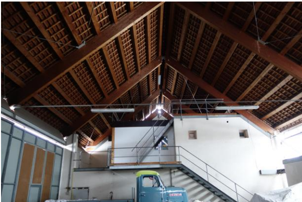
Abbildung 31: Innenansicht des ehemaligen BayWa Gebäudes.
